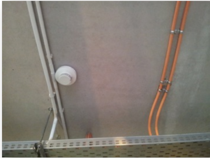
Rys. 1 Po lewej kabel sygnałowy SSP, po prawej kabel sterujący przeznaczony do pracy w czasie pożaru.
