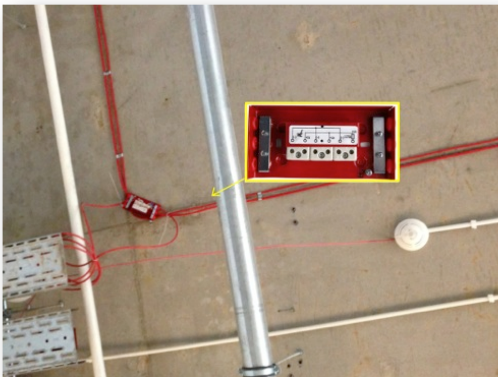
Rys. 7. Puszka połączeniowa PIP-2A. Widoczne są ceramiczne, odporne na wysoką temperaturę kostki montażowe. (fot. `Ela-compile).
